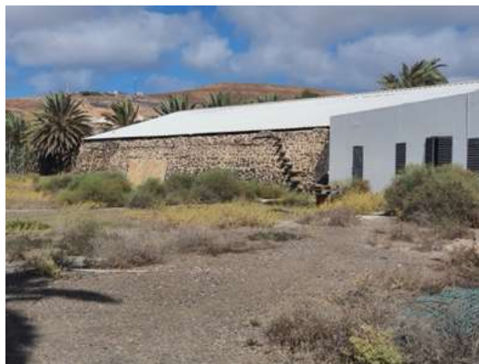
Almacén/estanque subsector norte
