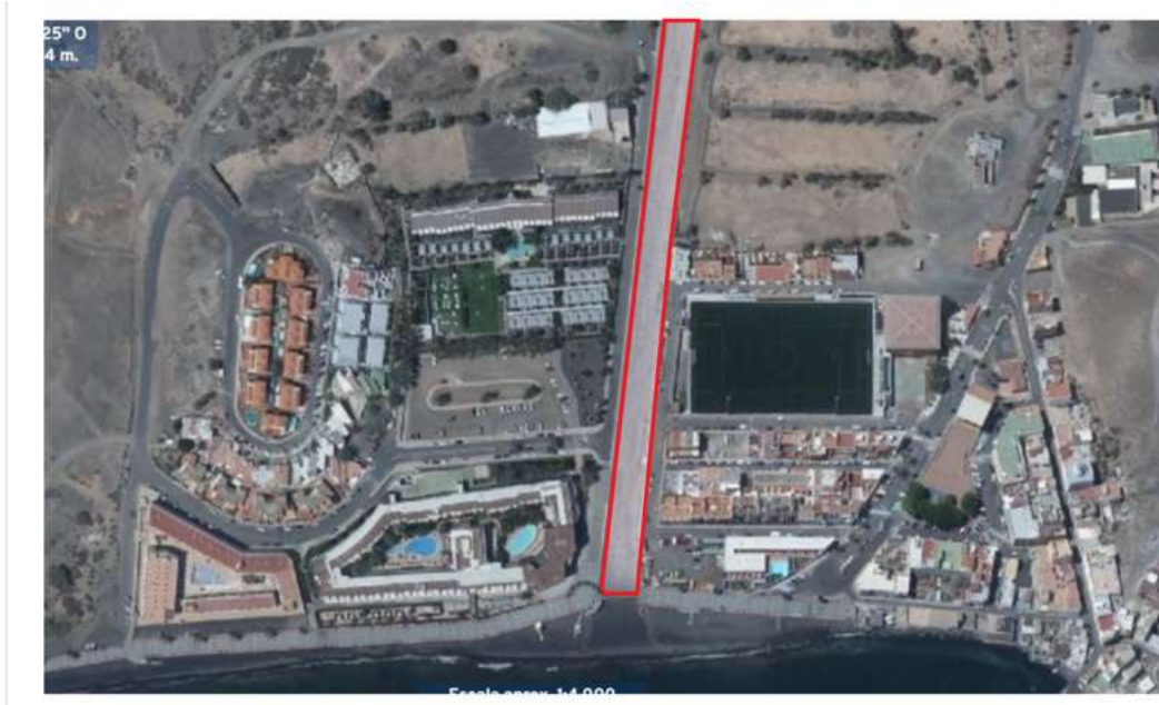
Cauce del barranco canalizado (línea roja)
