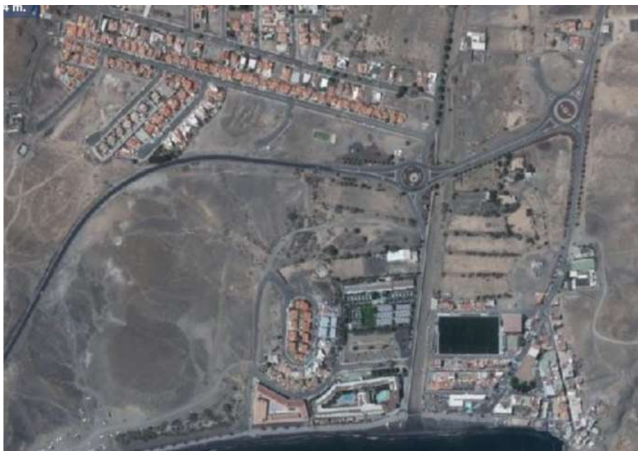
Estructura del viario estructural de Tarajalejo
